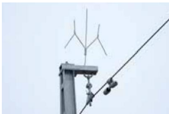
3.6.2.5 pav. Ant stulpų, kad nenutūptų dideli paukščiai, montuojamas įrenginys „Šakutė“
